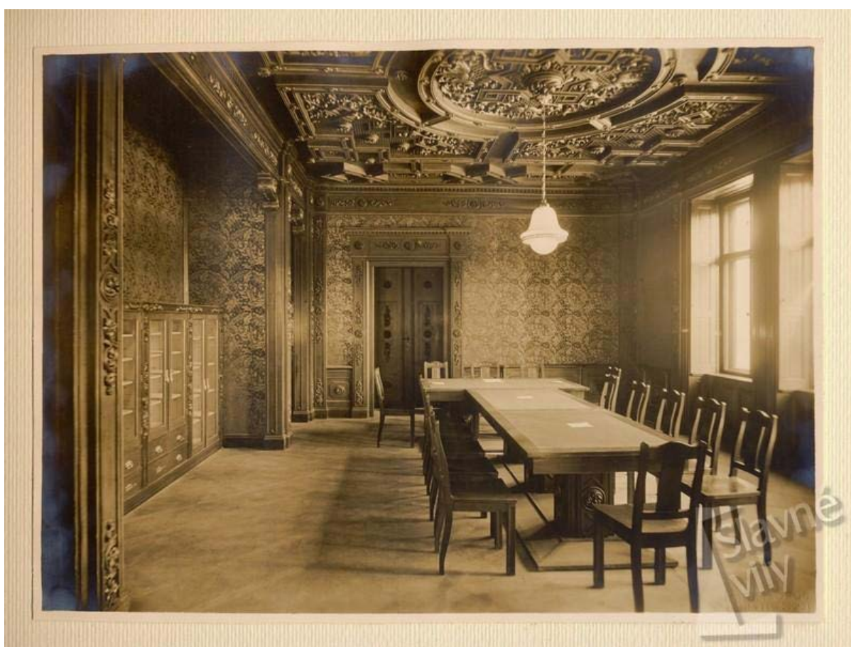
Interiér Leitenbergerovy vily - dnes zcela zničený
